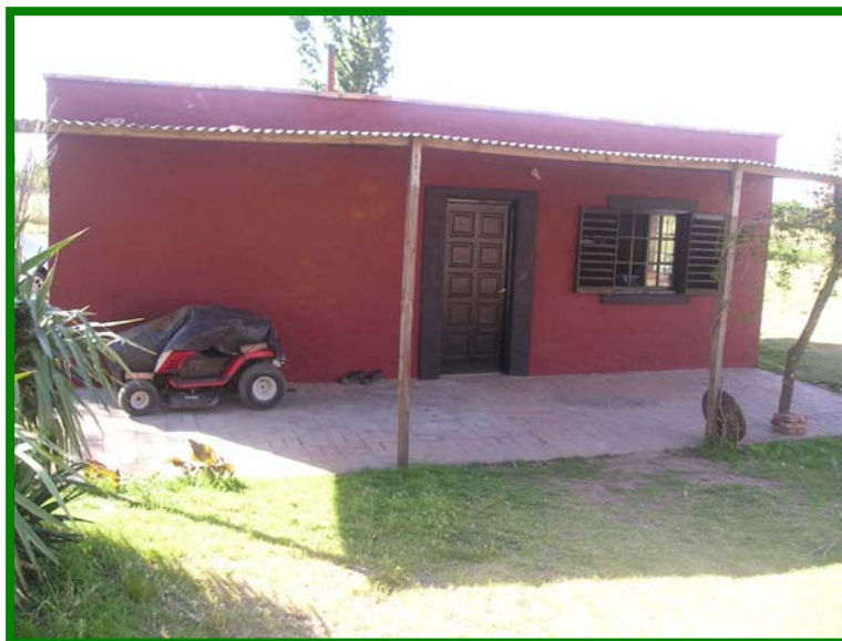
Foto 2.- Una de las casas (50 m2) un dormitorio, cocina-comedor, baño y galería
