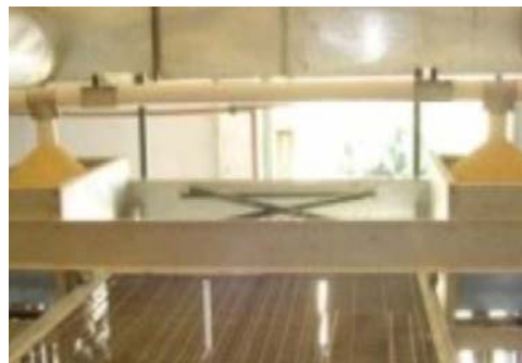
Foto 4.- Llenado de tolvas desde silo.
