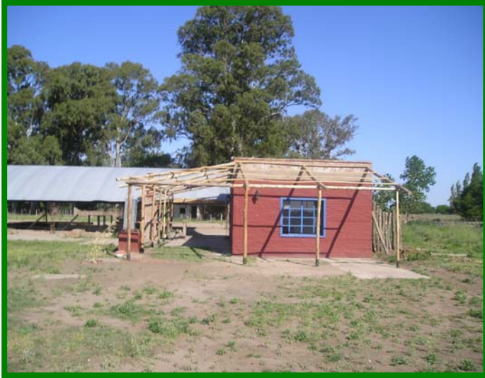
Foto 3.- Segunda casa (50m 2 ). Tiene un dormitorio, estar-comedor, baño y tiene prevista una galería con parrilla. En el fondo a la izquierda se puede ver el tinglado de 15 metros por 32 metros.
